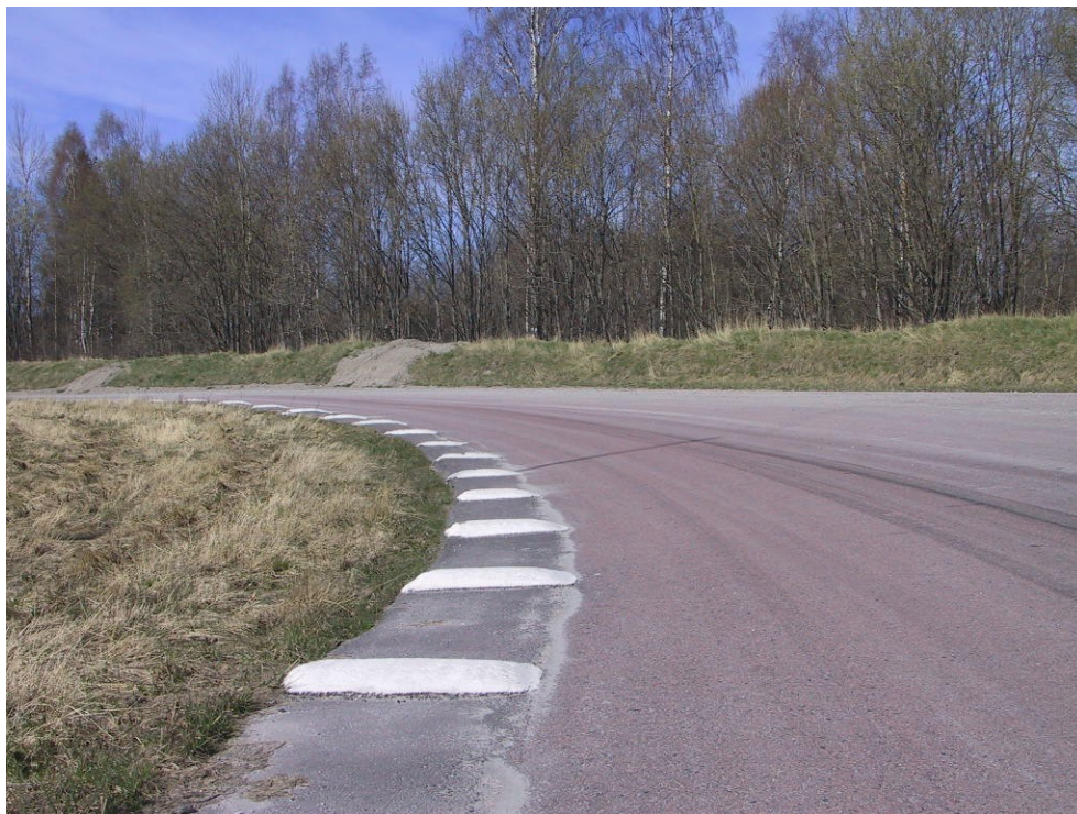
Curbs formade av asfalt. Kan även utföras med betong.
