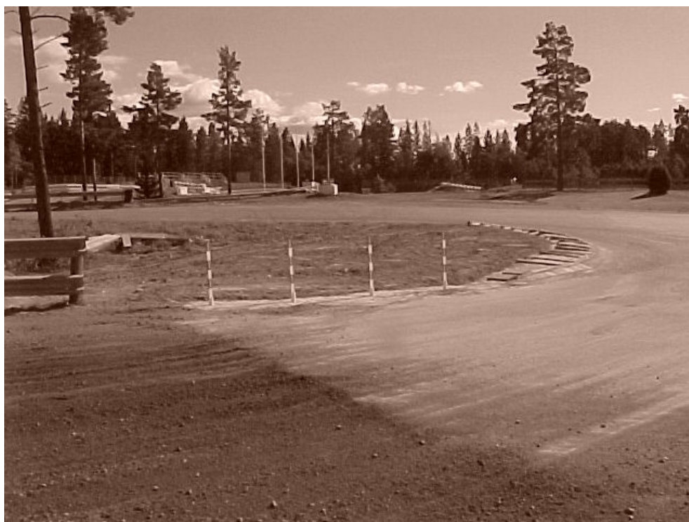
Ingjutna trästolpar. Ingången i kurvan extramarkerad med plaststolpar.
